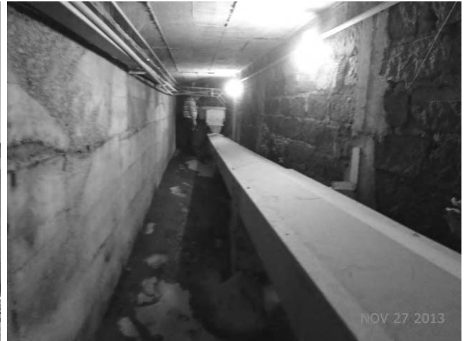
TRANSPORTADOR SOB SILOS
