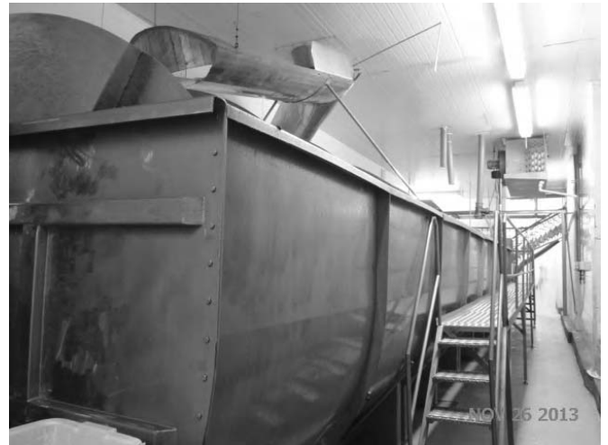
CHILLER DE INTEIROS
