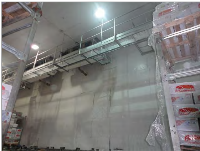
4. Abatedouro – câmara de congelamento.
