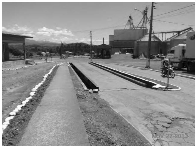
PLATAFORMA DA BALANÇA RODOVIARIA
