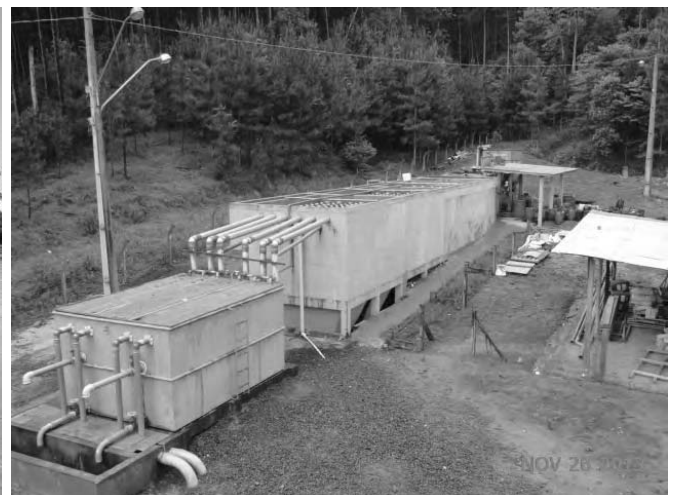
ETA – ESTAÇÃO DE TRATAMENTO DE AGUA
