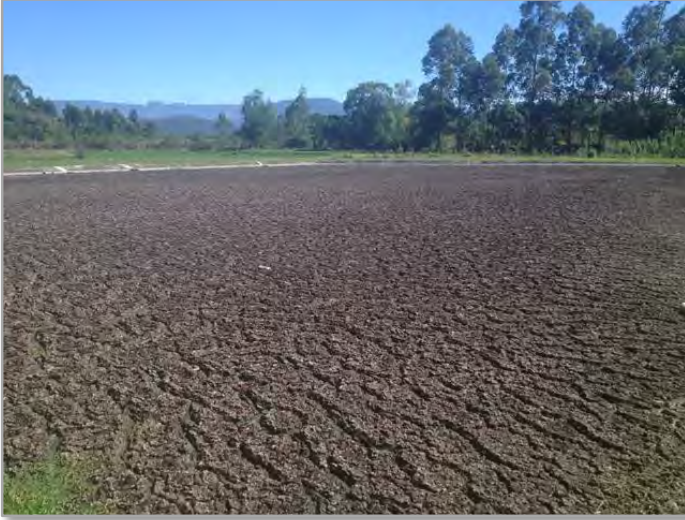
70. Matrícula 23.205 – detalhe da lagoa anaeróbica.
