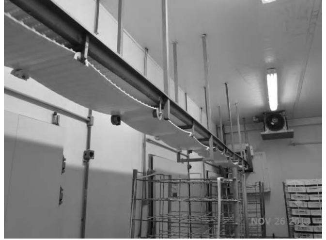
ESTEIRA ELEVADA E EVAPORADOR
