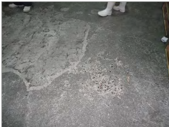
5. Abatedouro – detalhe do piso da câmara de congelamento.
