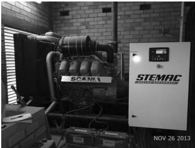
GERADOR TRIFASICO TURBO DIESEL
