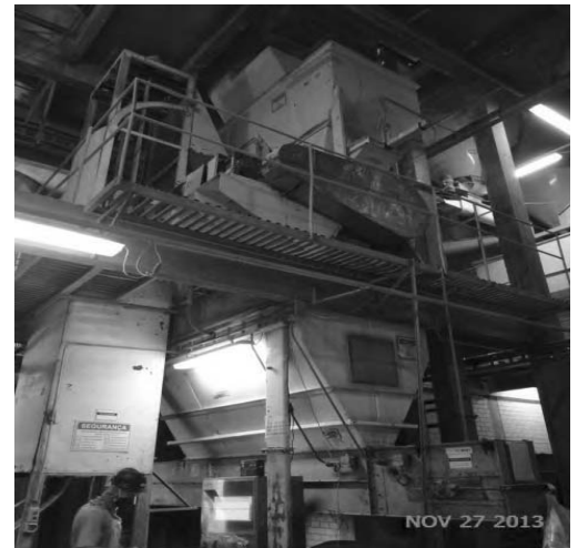
MISTURADOR E SILOS SUPERIOR E INFERIOR
