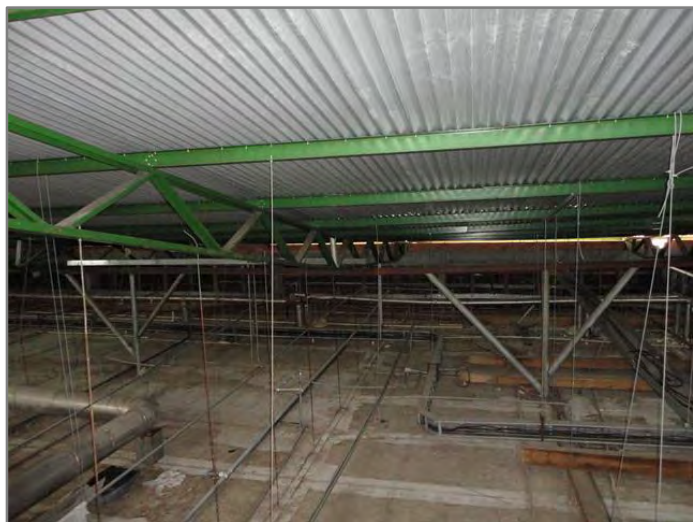
18. Abatedouro – detalhe da estrutura da cobertura.
