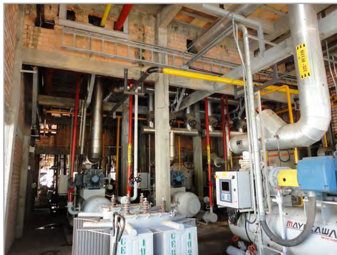
47. Casa de máquinas – detalhe do interior.
