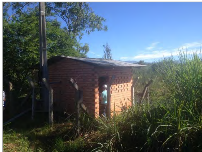
68. Casa da bomba – captação de água do rio.
