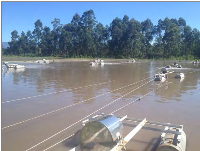
72. Matrícula 23.205 – detalhe da lagoa aerada.
