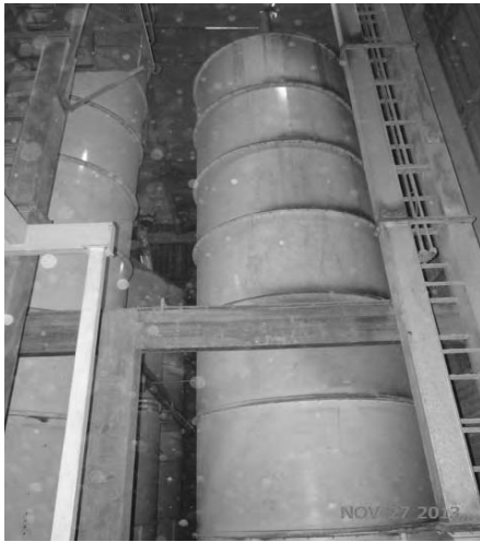
SILOS DE DOSAGEM
