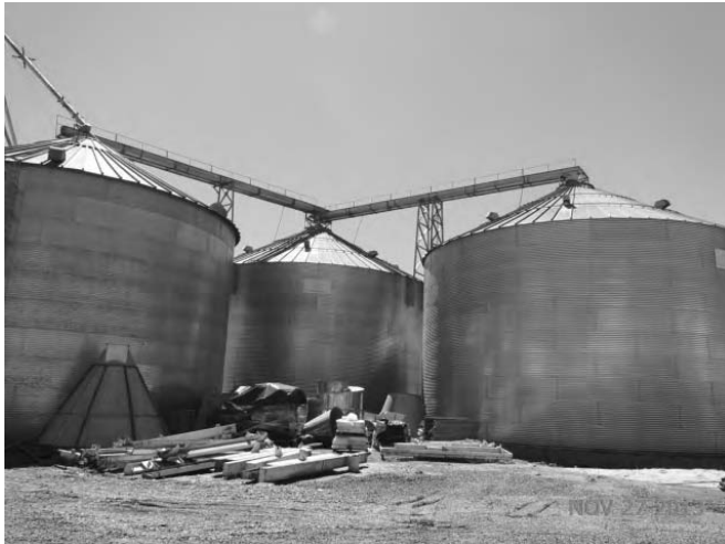
SILOS DE 1 500 T EXTERNOS
