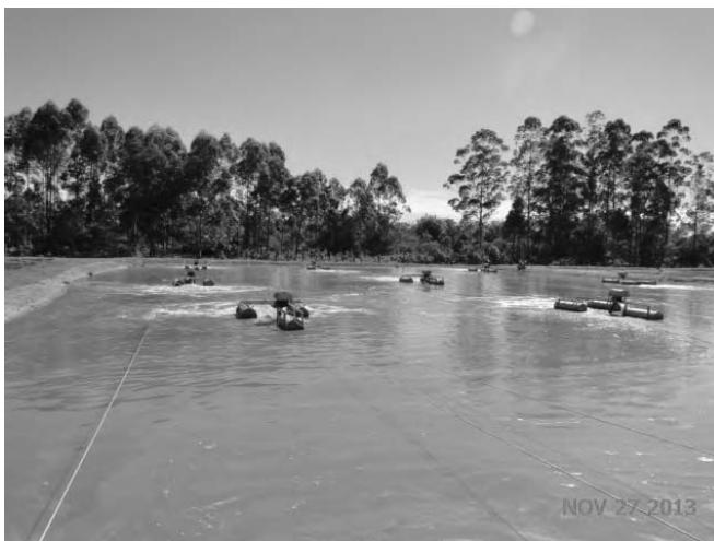
LAGOAS DE AERAÇÃO
