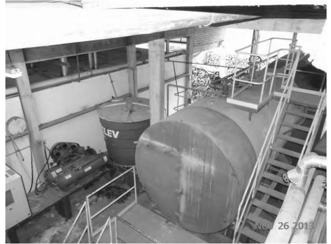
CALDEIRA E COMPRESSORES
