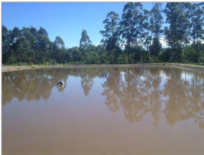
73. Matrícula 23.205 – detalhe da lagoa de decantação.
