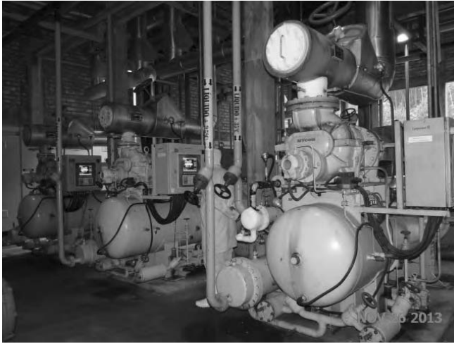
COMPRESSORES DE REFRIGERAÇÃO
