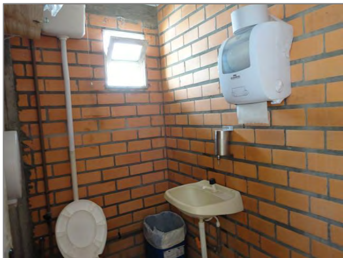
48. Casa de máquinas – detalhe de um banheiro.
