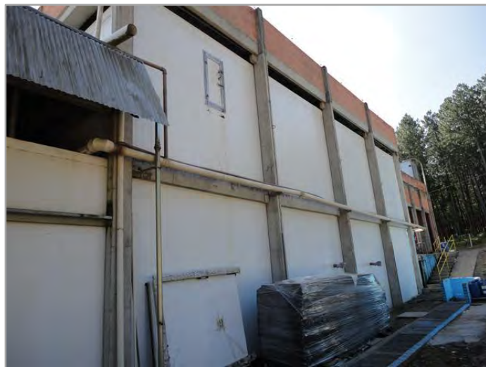
17. Abatedouro – detalhe da fachada.
