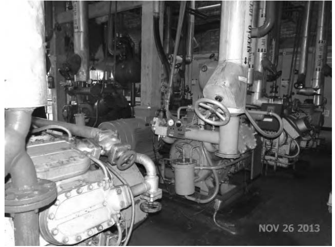
COMPRESSORES DE REFRIGERAÇÃO
