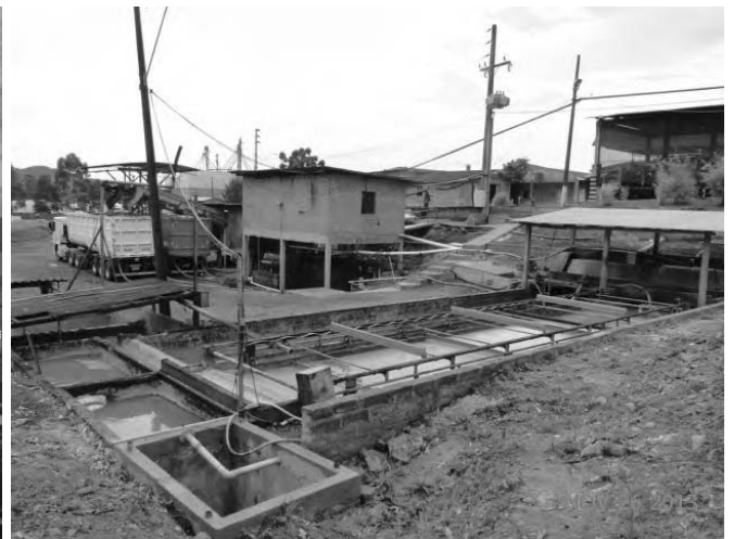
ETE – ESTAÇÃO DE TRATAMENTO ESGOTO
