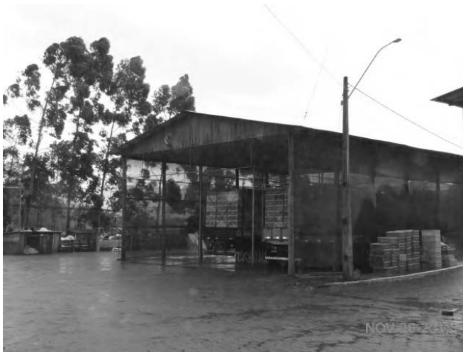
GALPÃO DE ESPERA DE CAMINHÕES
