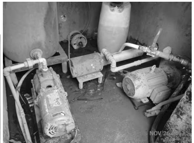
BOMBAS DA LAVAGEM DE CAMINHÕES
