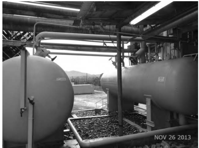
RESERVATÓRIOS DE AMONIA
