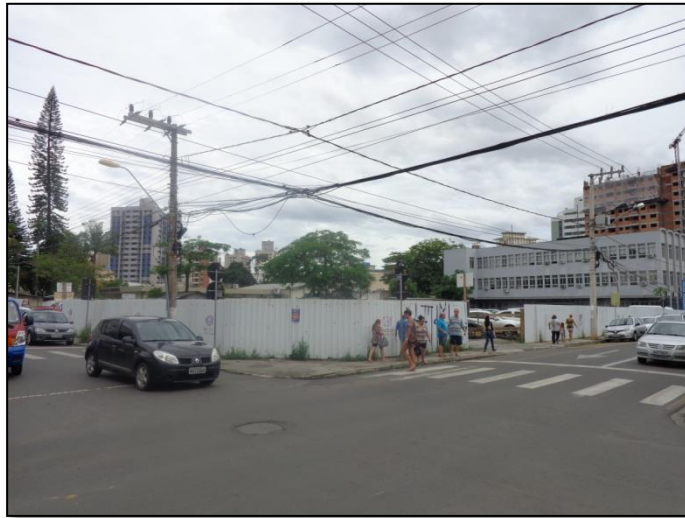
Imagem 01 – Vista frontal do imóvel.
